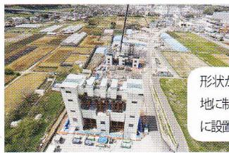
形状が複雑な場合や用地に制約がある場合などに設置する鋼製の橋脚
