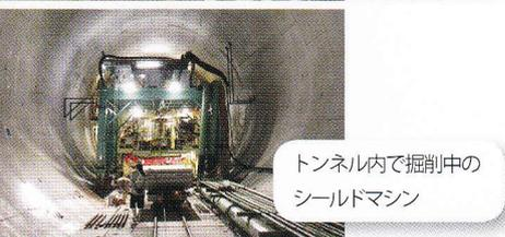
トンネル内で掘削中のシールドマシン
