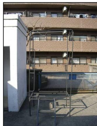
③上部一体型フレームと下部一体型フレームを差し込んで連結させ、トイレの骨組みを完成させます。
