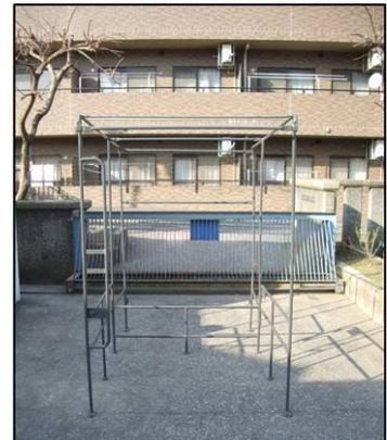
③上部一体型フレームと下部一体型フレームを差し込んで連結させ、トイレの骨組みを完成させます。
