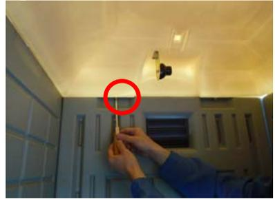
側面パネルに天井パネルを取り付けます。
