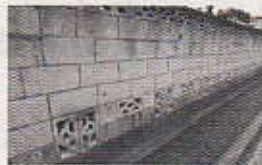
コンクリートブロック塀
