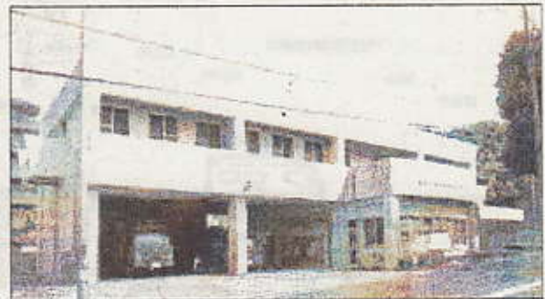
荏田消防出張所の全景
