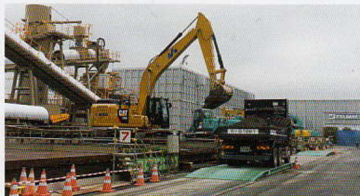
土がトラックに積まれる様子
