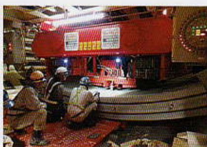
トンネル内での組立て作業の様子
