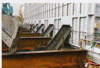
分離された土が排出される様子
