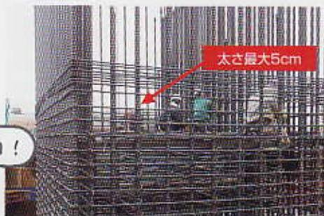
コンクリート橋脚の鉄筋
