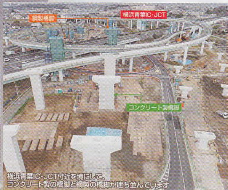
横浜青葉IC・JCT付近を境として、コンクリート製の橋脚と鋼製の橋脚が建ち並んでいます
