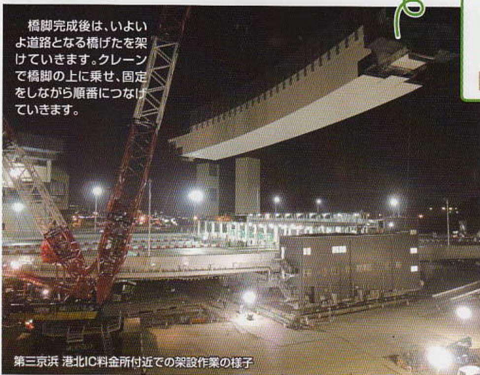
第三京浜 港北IC料金所付近での架設作業の様子
