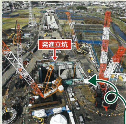
北八朔町 発進立坑(地上部)
